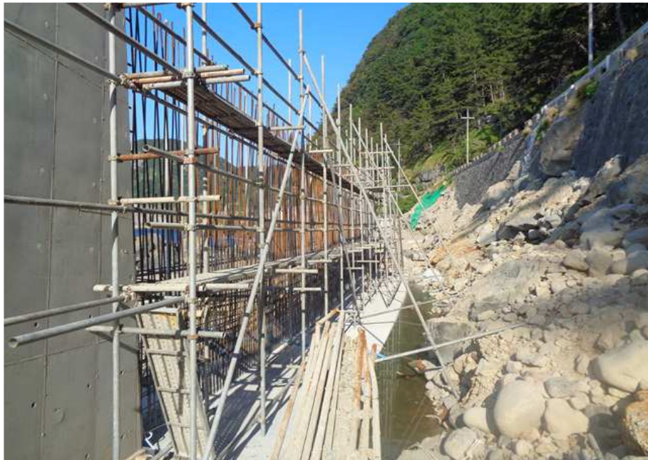
STA 0+745 ~ 0+760 옹벽 배면 강관 비계 설치 전경
