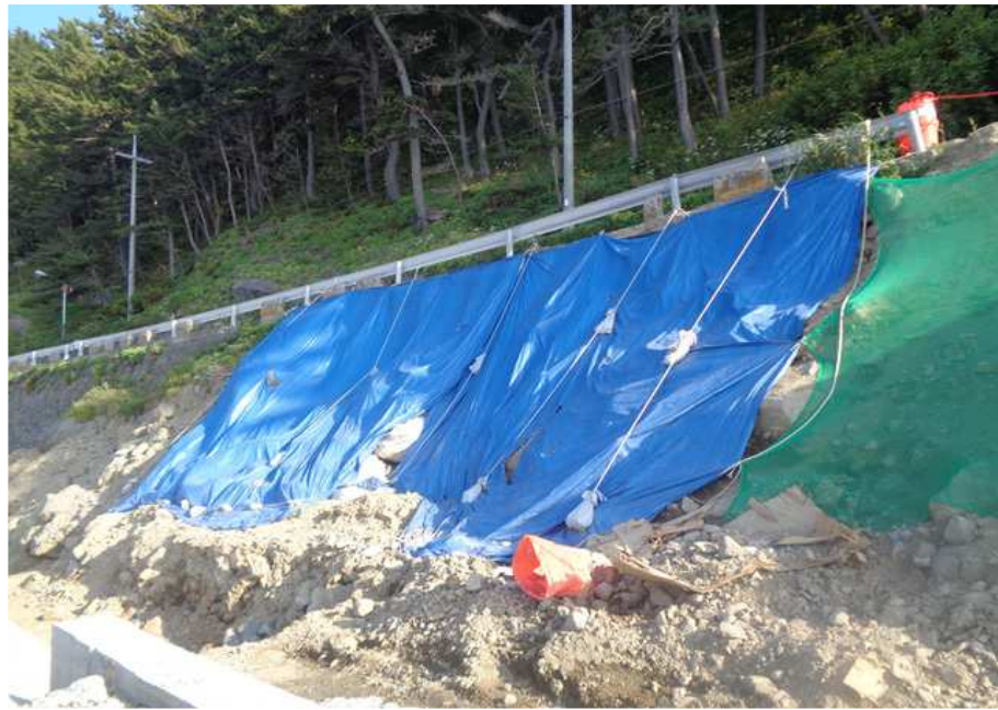
옹벽 배면 지반노출부 우수유입방지막 설치 전경
