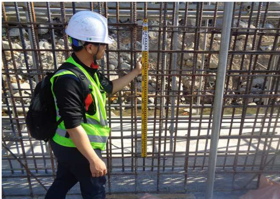
STA 0+745 ~ 0+760 벽체 철근 배근 현황
