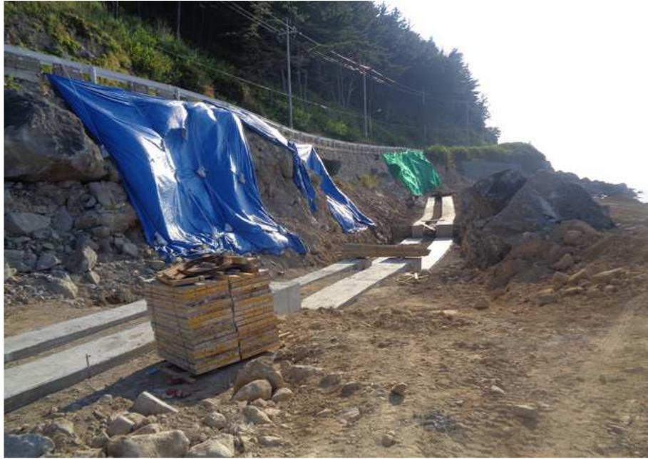
기초터파기 및 버림 콘크리트 타설 현황
