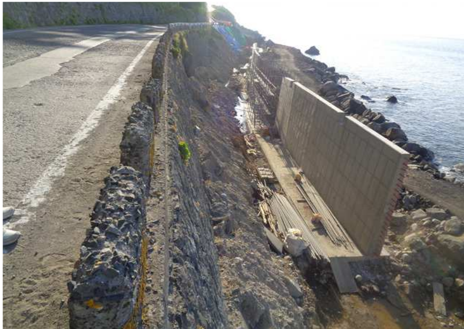
6지구 2구간(STA 0+620 ~ 0+800) 옹벽 배면 전경
