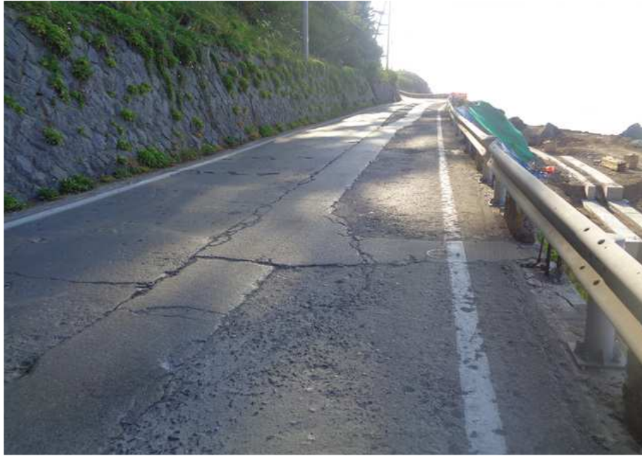
STA 0+620 ~ 0+800 용벽 배면 석축 상부 도로 현황
