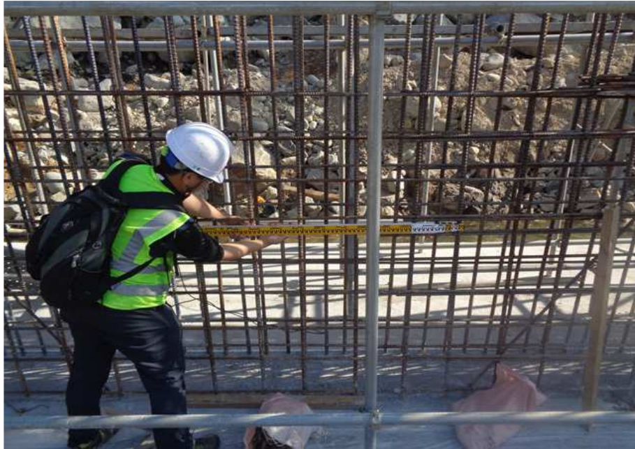
STA 0+745 ~ 0+760 벽체 철근 배근 현황
