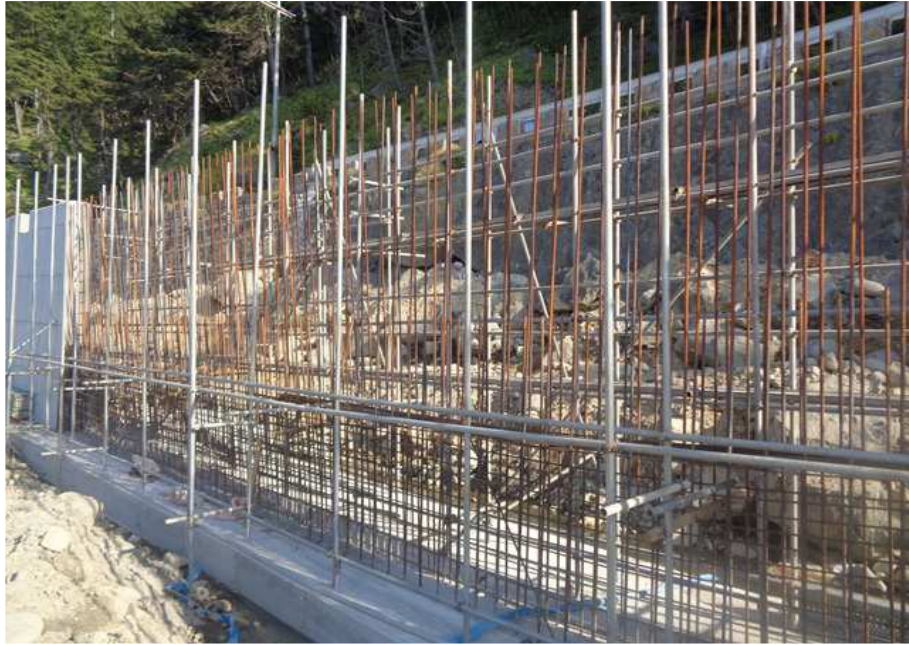
STA 0+745 ~ 0+760 옹벽 전면 강관 비계 설치 전경
