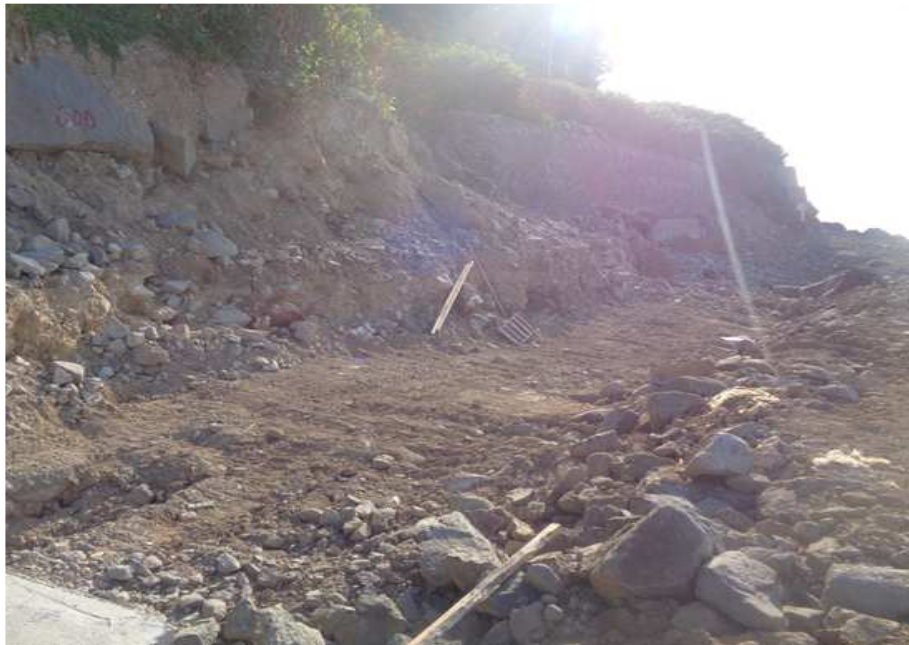
기초터파기 및 버림 콘크리트 타설 현황
