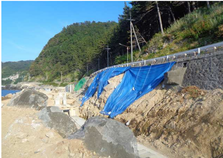
STA 0+620 ~ 0+800 용벽 배면 석축 하부 현황
