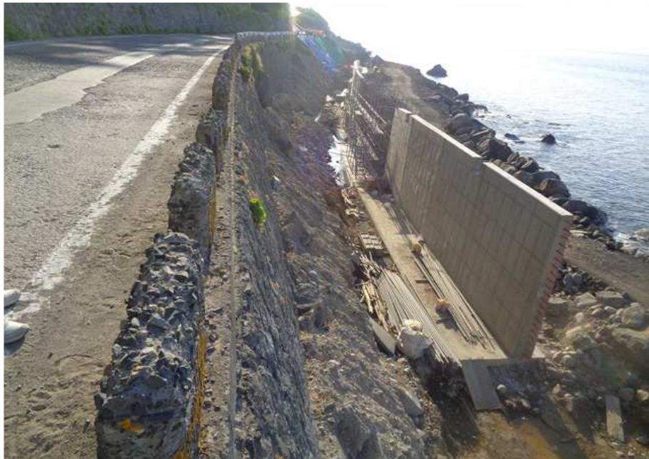
기초, 벽체 콘크리트 타설 현황
