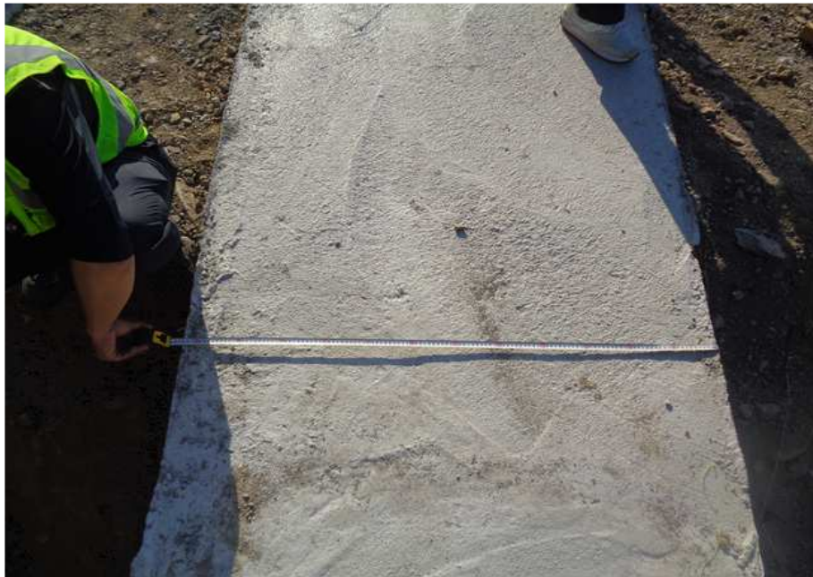
압굽 버림 콘크리트 폭 측정 1,230mm
