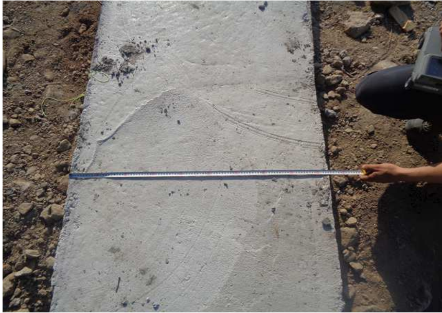
뒷굽 버림 콘크리트 폭 측정 930mm
