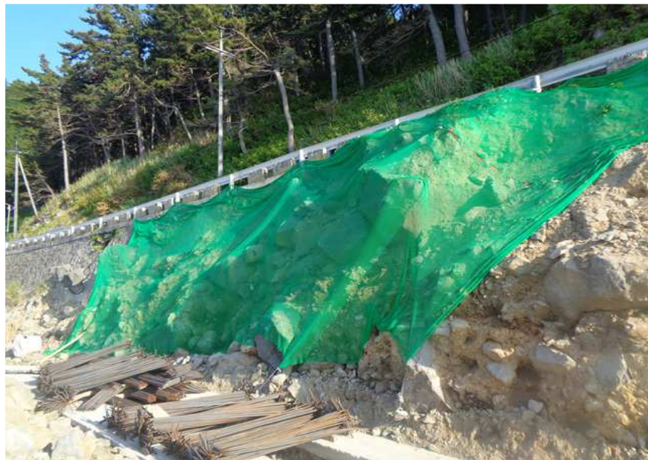
옹벽 배면 지반노출부 우수유입방지막 설치 전경
