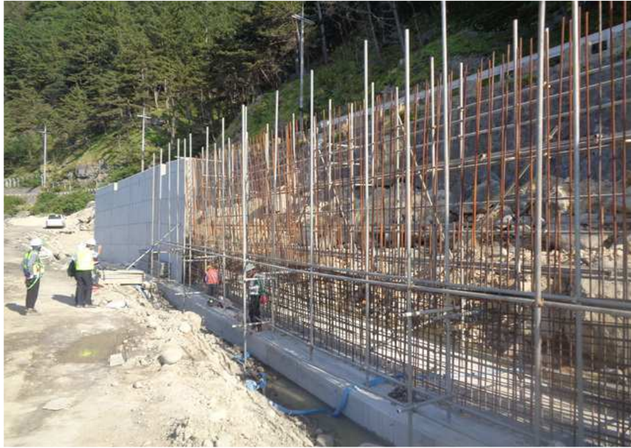
STA 0+745 ~ 0+760 벽체 철근 배근 현황
