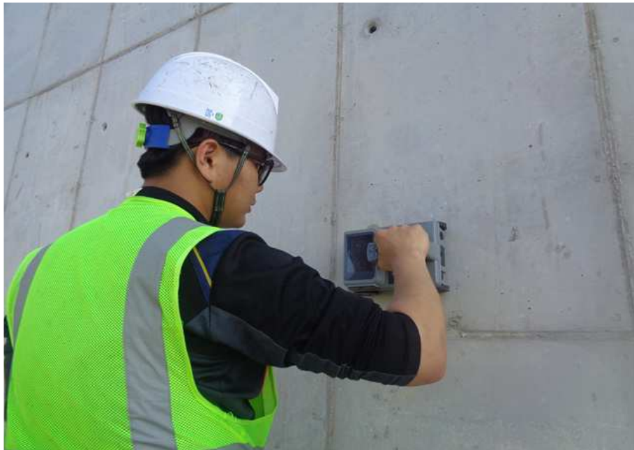
벽체 철근 배근 탐사 현황
