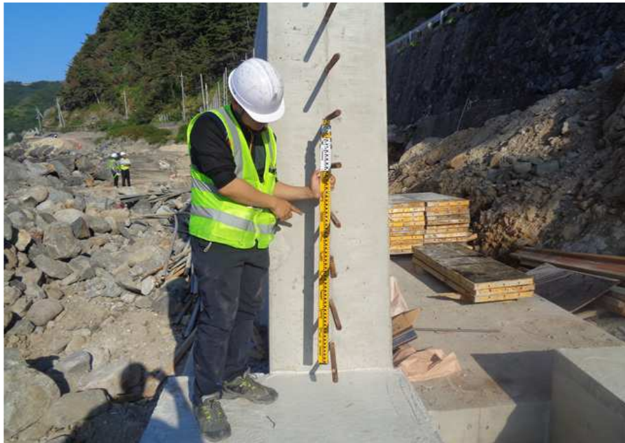
STA 0+745 ~ 0+760 벽체 다웰바 배근 현황
