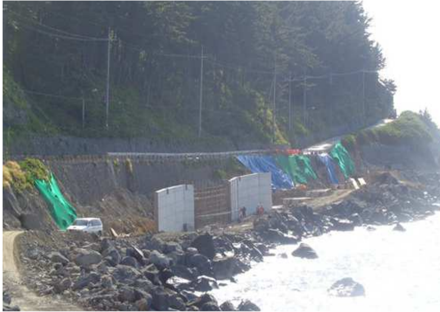
6지구 2구간(STA 0+620 ~ 0+800) 옹벽 전면 전경
