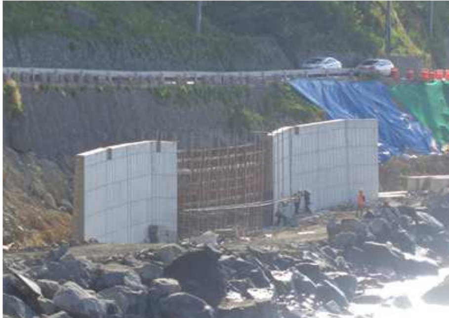
기초, 벽체 콘크리트 타설 현황
