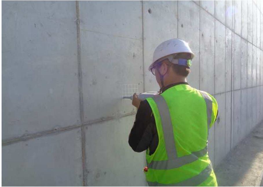
콘크리트 강도 측정 현황
